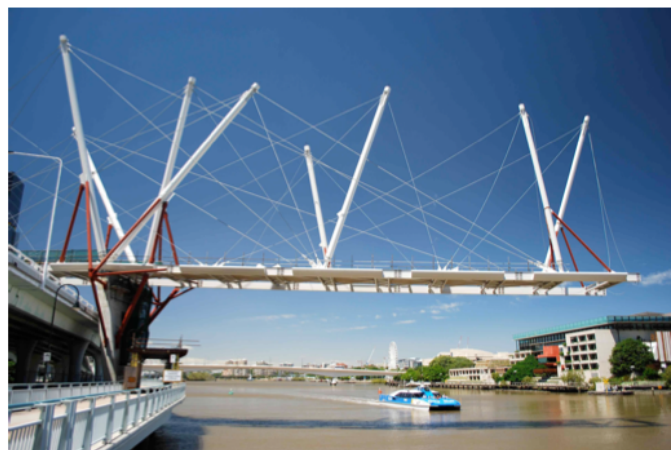
(d) Tank Street Bridge in Brisbane
